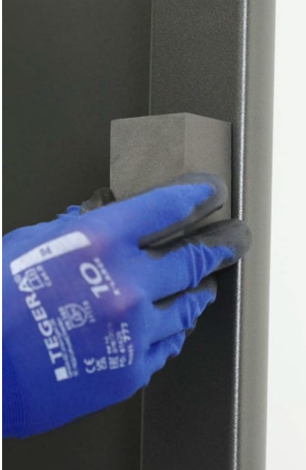
Abbildung 38: Abstandshalter positionieren
